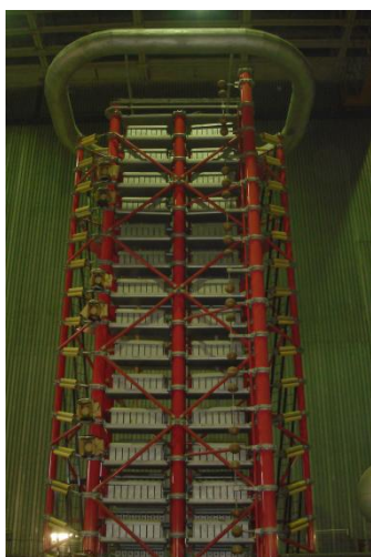
генератор импульсных напряжений 4 МВ
