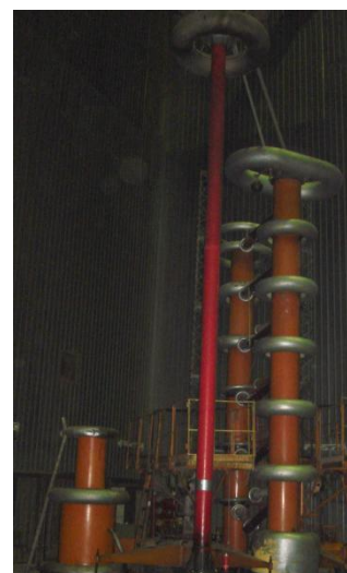
испытательная установка постоянного напряжения 1800 кВ
