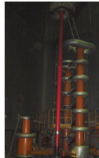
испытательная установка постоянного напряжения 1800 кВ
