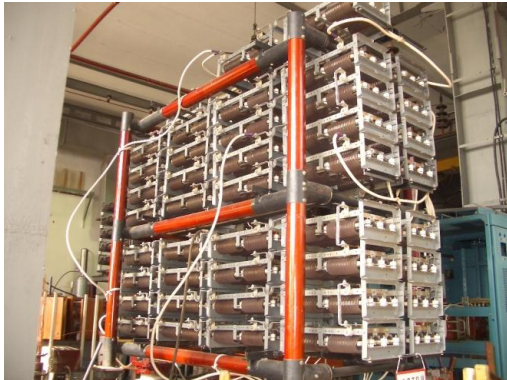
Стенд токовых испытаний: ток до 2500 А, напряжение 500 В
