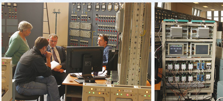
Испытания ГРАМ Братской ГЭС
