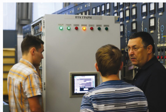
Испытания ГРАМ Усть-Каменогорской ГЭС
